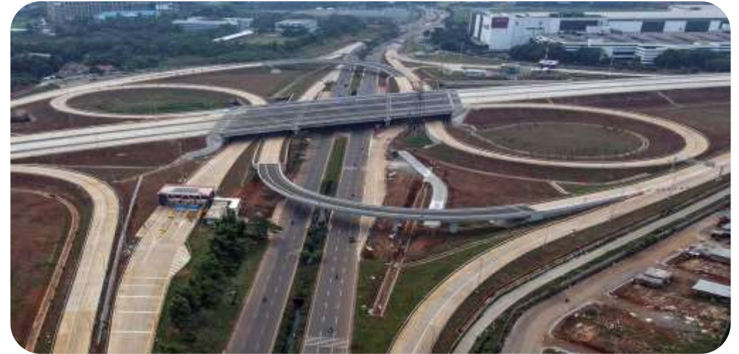
Jalan Tol Serbaraja (fase 1)
